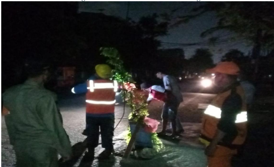
Gambar 5.1.5. Penanganan Prasarana Dan Sarana Penerangan Jalan Umum
